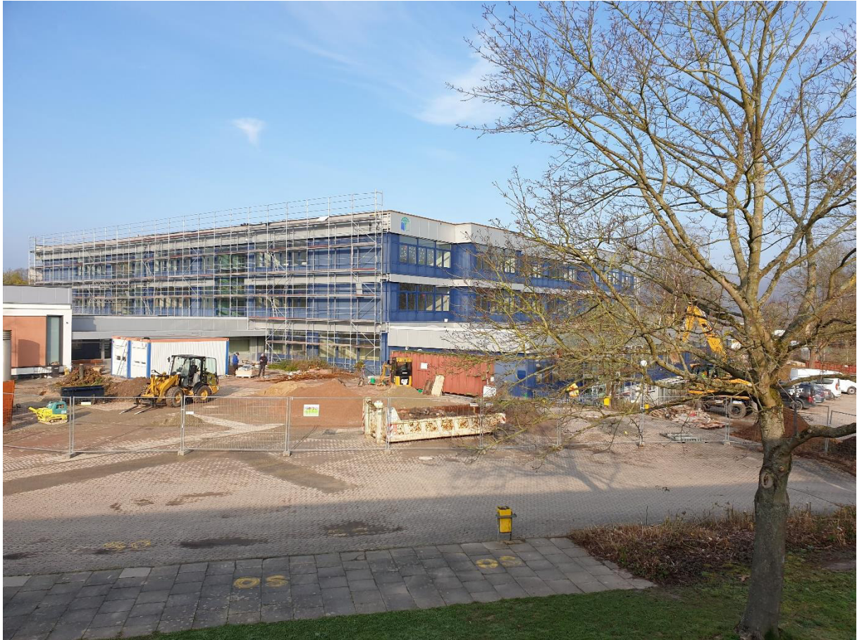
Auf der Baustelle Liebigstraße
